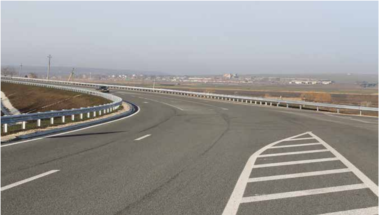
Kraj: Mołdawia Projekt: Kiszinew - Soroka Autostrada
